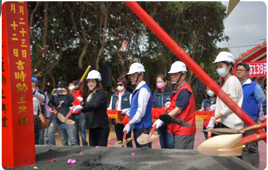
▲投 139 丙線二期工程動工
