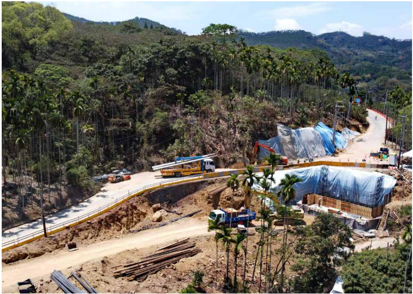
▲空中俯瞰環鄉道路工程
