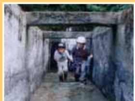
◆橫跨馬鄰溪上的水橋
