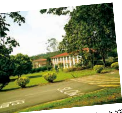
紅瓦白牆的校舍建築
