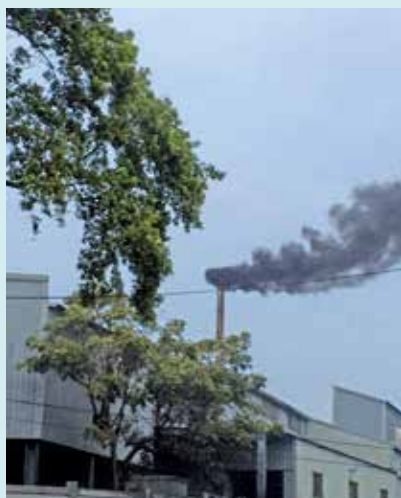
燃油鍋爐冒出黑煙囪造成空污
