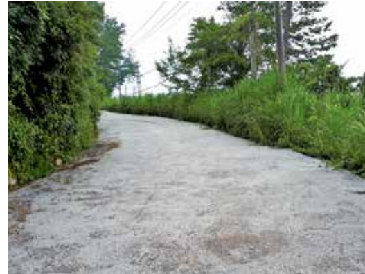
路面坑洞改善後
