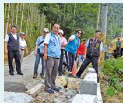
林縣長會勘水里鄉農路搶修及護岸補強工程指示速改善
