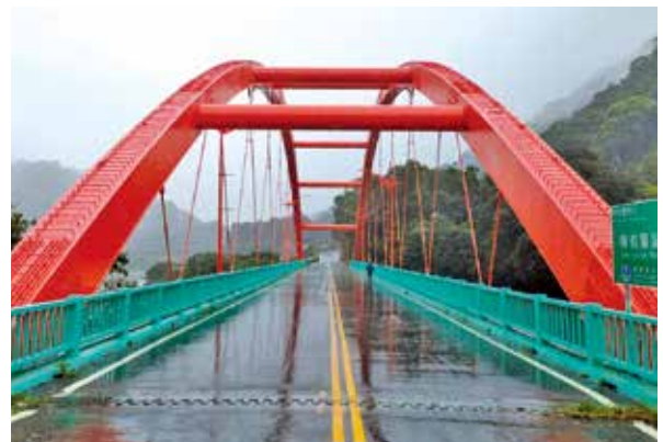
信義鄉投 60 線和社橋 - 鋼橋除鏽及上漆完成
