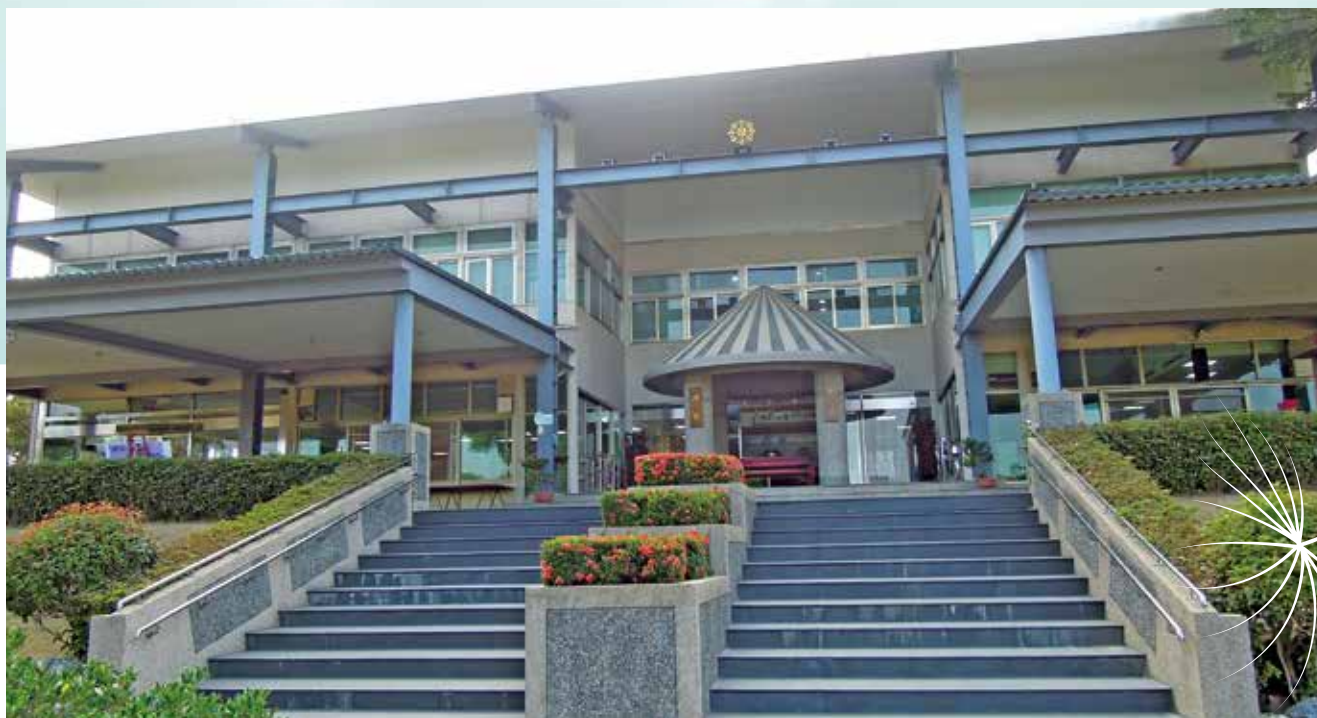
類似集合式住宅外觀的現代納骨設施
