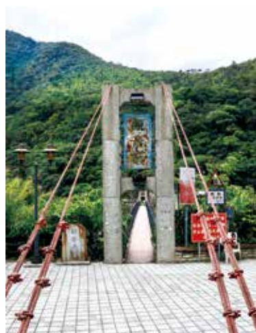
台14線路旁的觀音吊橋
