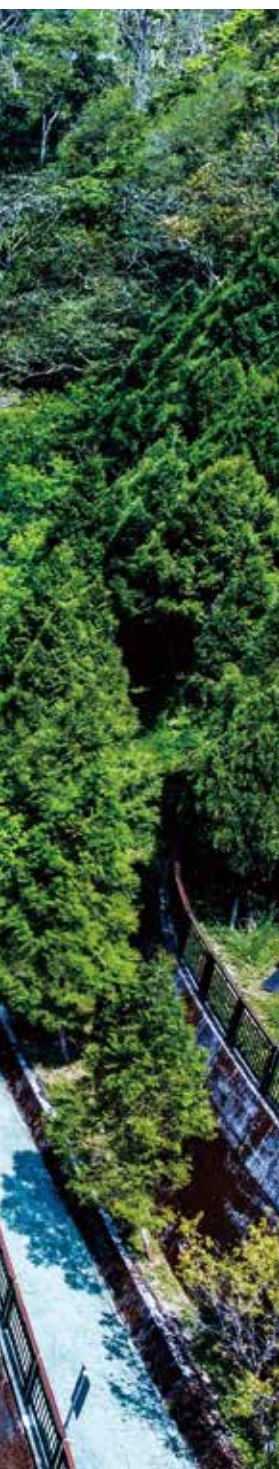
連接環湖步道兩岸的山龍坑吊橋
