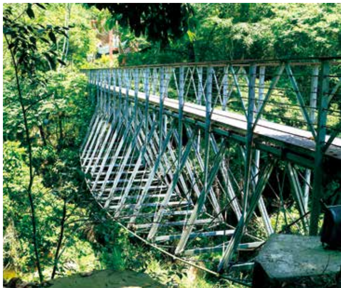
吊橋採用罕見的下懸式吊索結構
