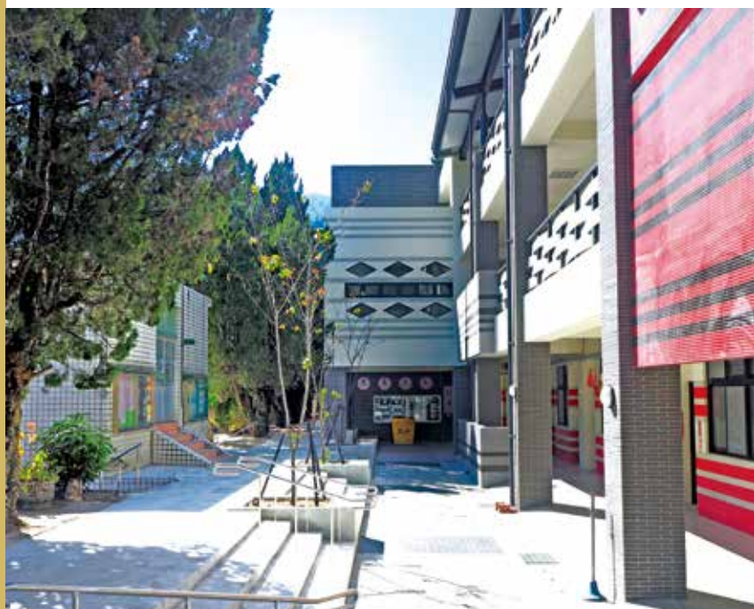
外部空間遵循賽德克傳統家屋下沉式設計，大階梯亦可成為戶外上課時的座椅。（南豐國小）
