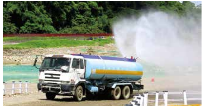
提高車行路徑及裸露區域防制比率（工區內灑水）
