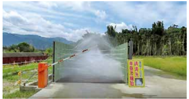
大型工程應設置跳動式自動洗車設備
