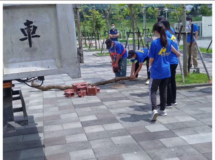
巨木倒塌電鋸切割搶通中
