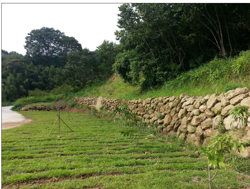
砌石擋土牆實例照片
