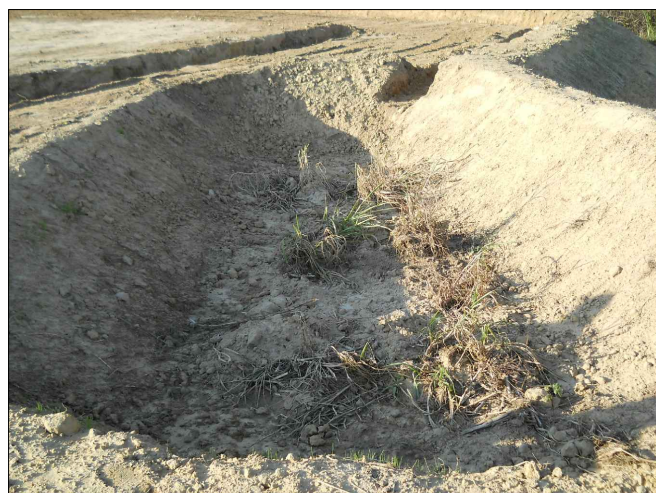
簡易農地沉砂池(土坡)實例照片
