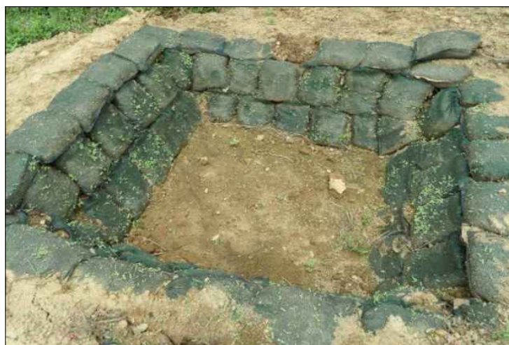
簡易農地沉砂池(土布袋)實例照片
