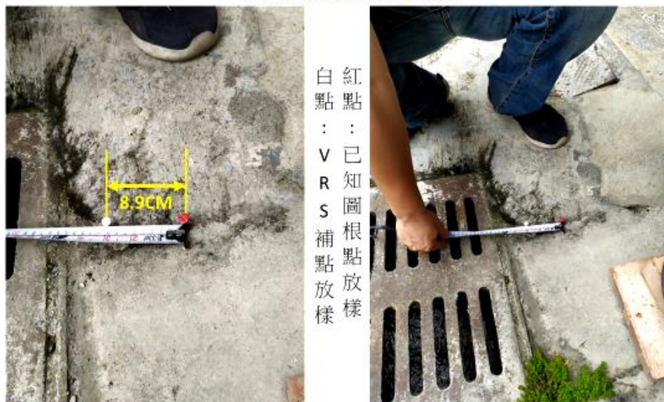
圖 19 現場實地放樣檢核現場照片
