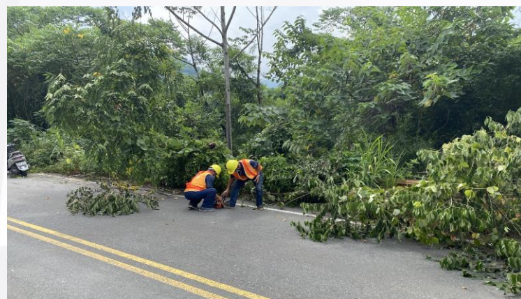
樹木倒塌影響通行，以電鋸切割 搶通中
