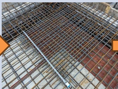
6. 角隅補強確認
