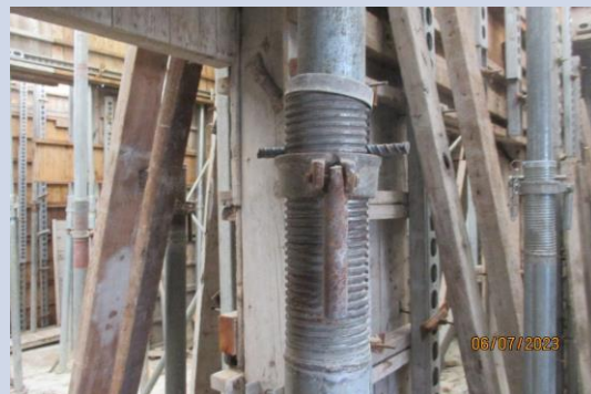
支撐架使用鋼筋當插銷
