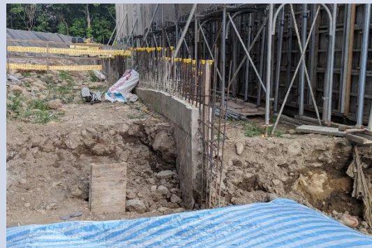
支撐架使用鋼筋當插銷
