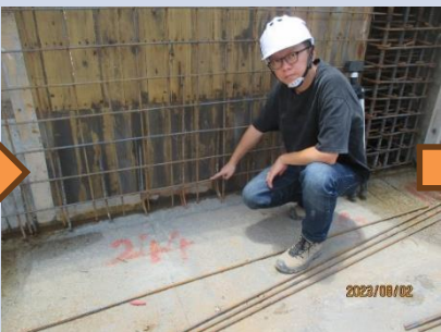
3. 上油，封板前底部清潔確認
