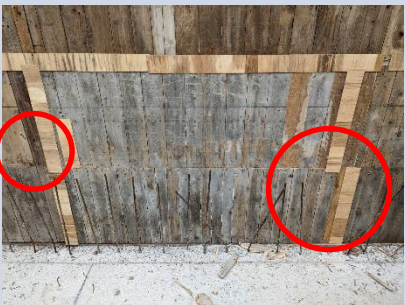
7. 發現使用破損模板，局部更換板材修補平整
