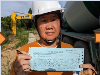
3. 確認運送時間、材料強度
