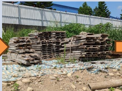
6. 拆模清潔後可再利用，不良品集中運出
