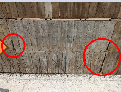
7. 發現使用破損模板，局部更換板材修補平整
