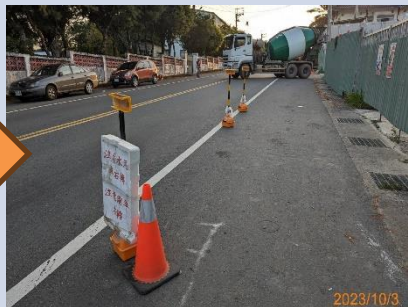
8. 控管澆置時間(道安交管設置)
