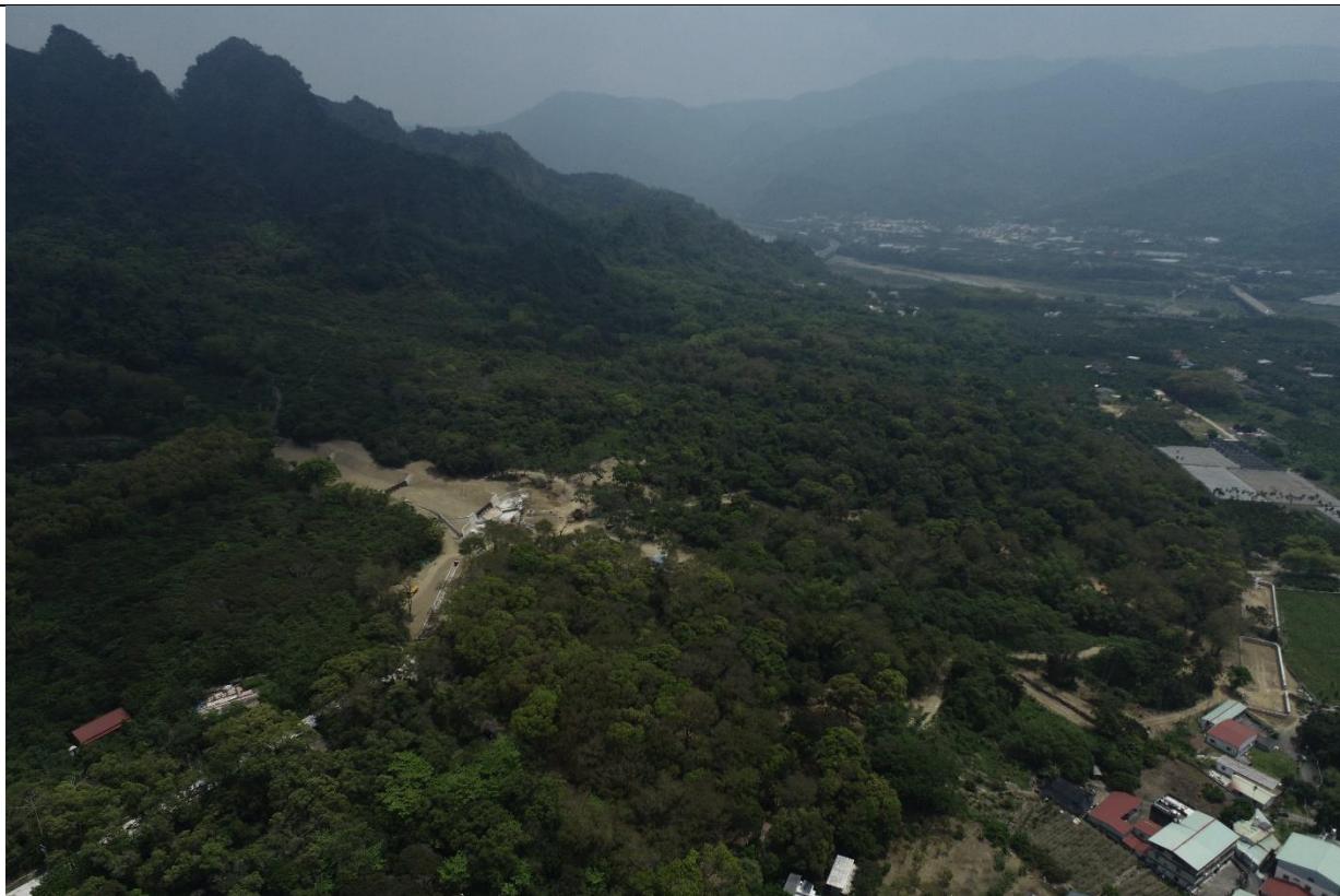
開發基地及北側水保工程空拍(2022/4/8)
