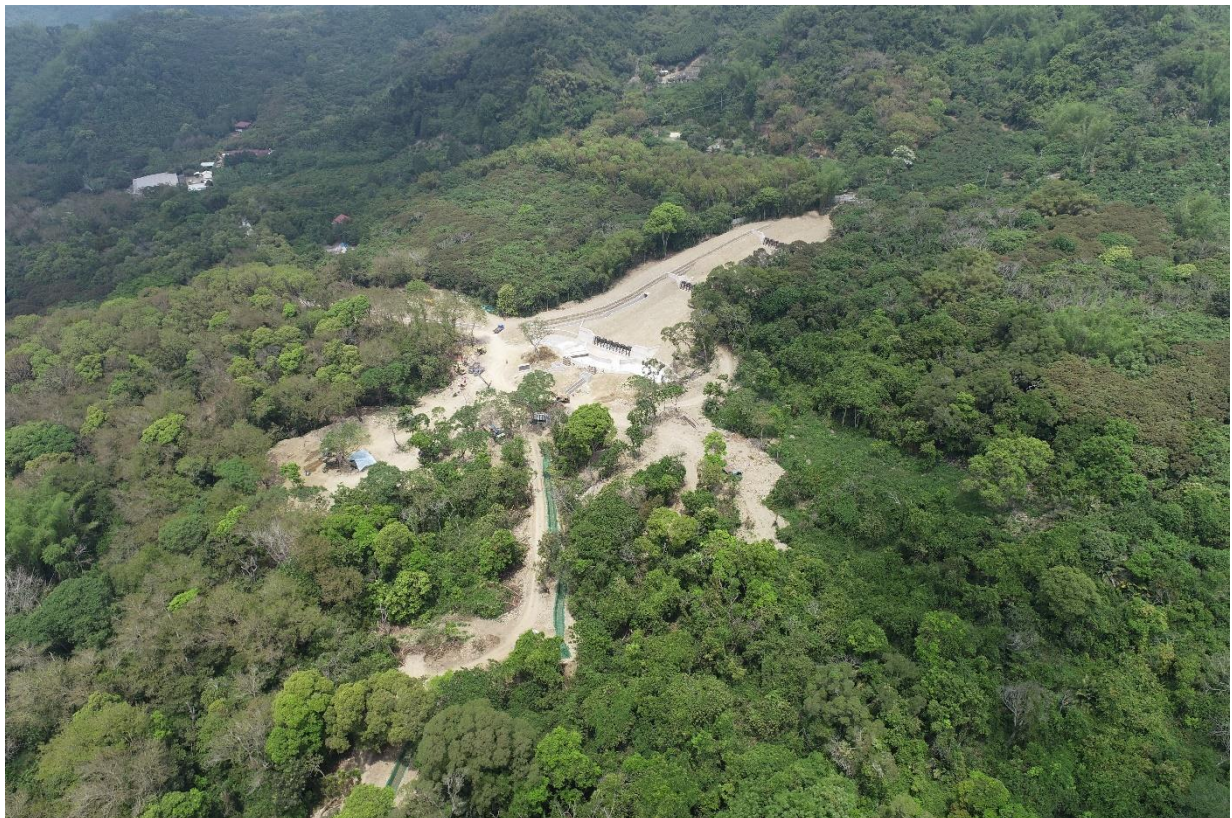
開發基地北側水保工程空拍(2022/4/8)
