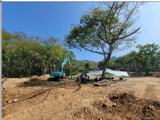
開發基地北側水保工程
