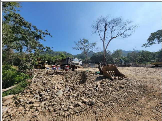
開發基地北側水保工程
