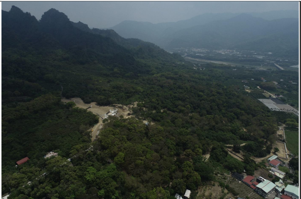
開發基地及北側水保工程空拍(2022/4/10)
