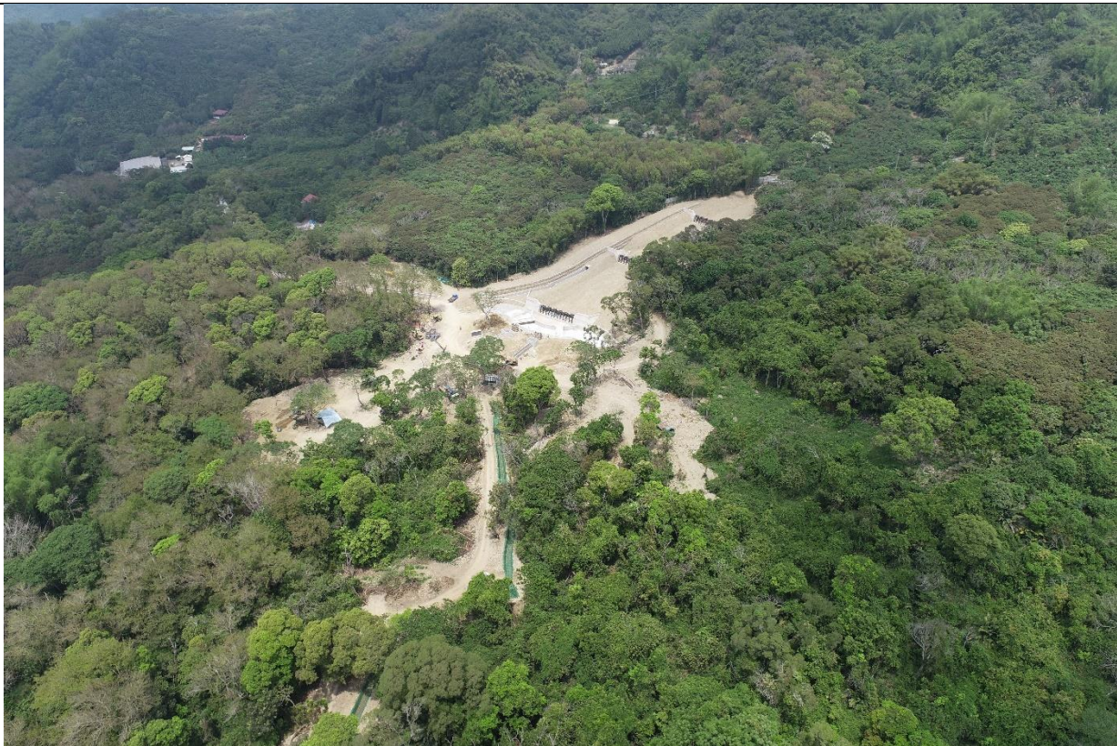
開發基地北側水保工程空拍(2022/4/8)
