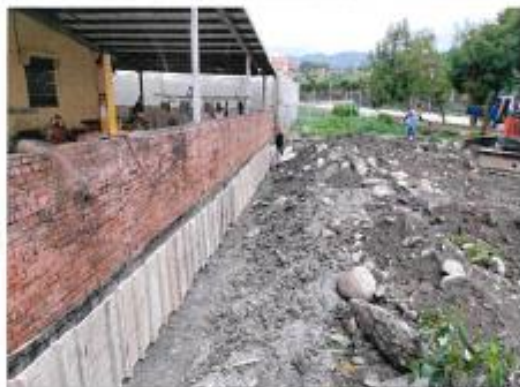
說明：8/25 擋土牆施工
