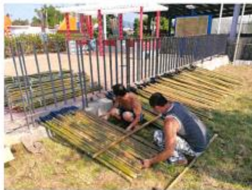
說明：8/26 竹牆施作
