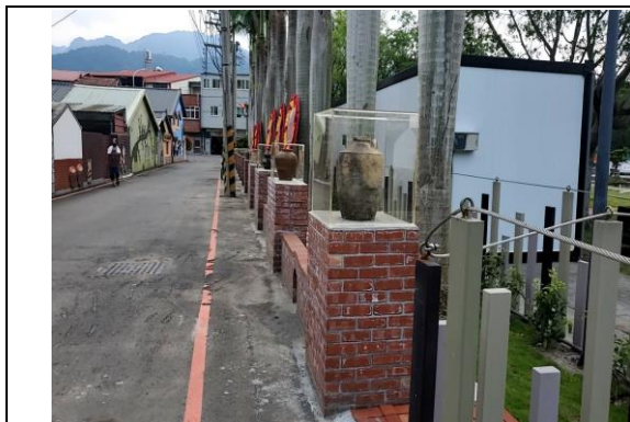
說明：完工狀況
