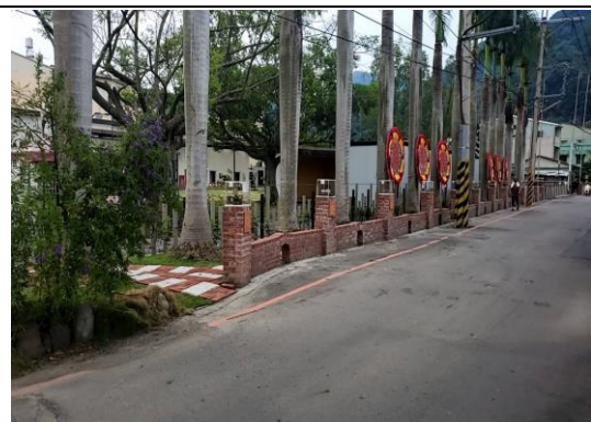
說明：完工狀況
