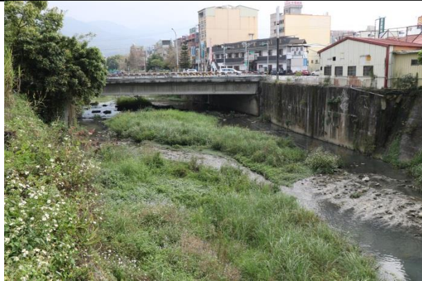
111/3/4 水岸及護坡照片(育英橋下游)
