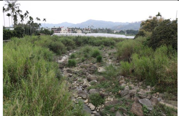
111/3/4 水岸及護坡照片(德昌橋下游)
