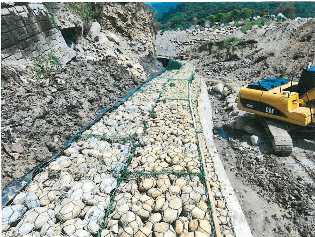
圖 2 施作石籠採用現地塊石及就近採購(114/4/30)
