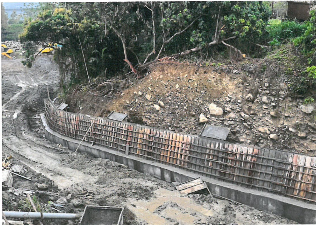
圖 2 施作護岸減少兩側生態擾動(114/3/31)
