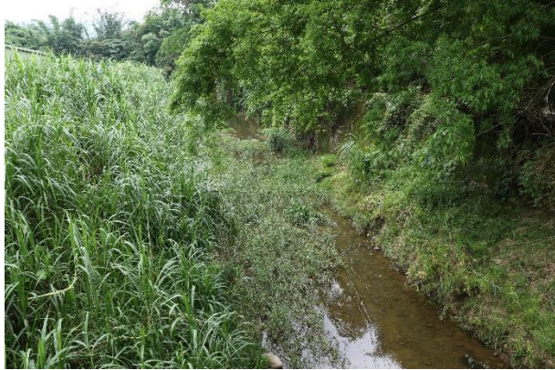
112/6/15 水岸及護坡照片
