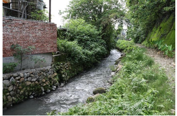
112/9/11 水岸及護坡照片
