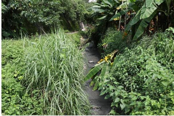
112/9/11 水岸及護坡照片
