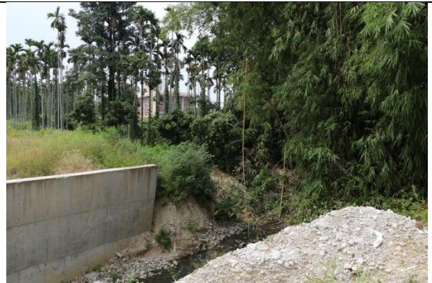
110/9/28 天然土坡照片(下游右岸)
