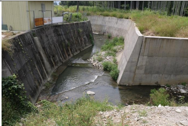
110/9/28 水岸及護坡照片(下游)
