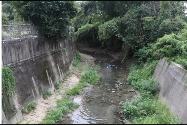
110/9/28 水岸及護坡照片(上游)
