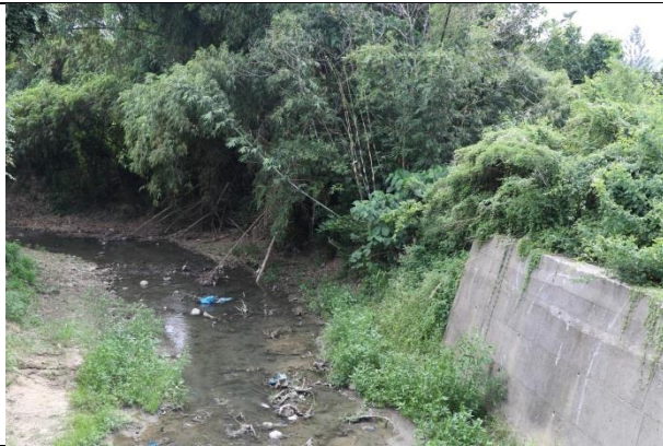
110/9/28 天然土坡照片(上游右岸)
