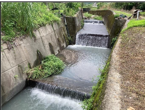
上游數階固床工，造成縱向生態阻隔
