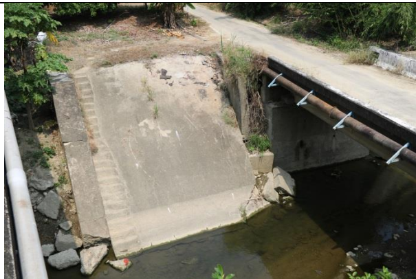
110/9/28 動物坡道照片(營豐橋)
