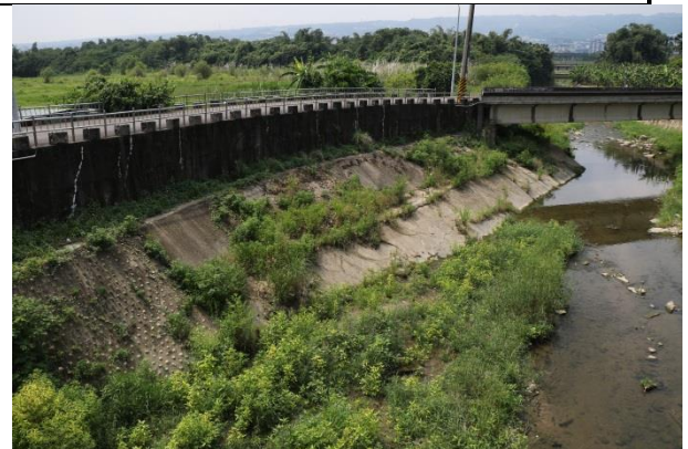
110/9/28 水岸及護坡照片(內力橋)
