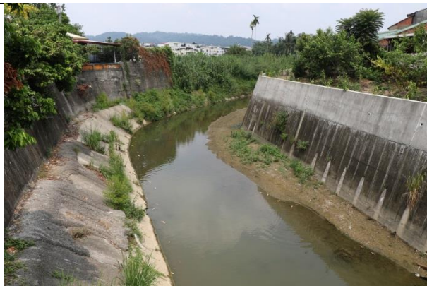
110/9/28 水岸及護坡照片(內轆橋)
