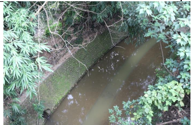
110/9/28 水岸及護坡照片(內轆新橋)
