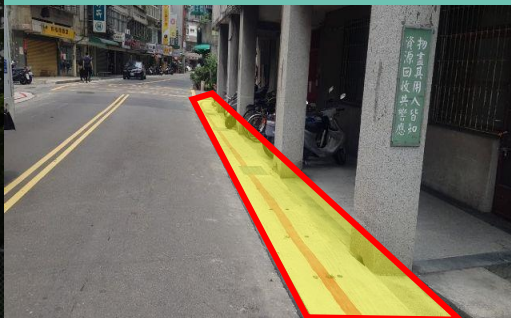
★ 側溝蓋道路附屬設施
