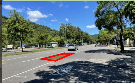
★ 熱再生坑洞搶修
