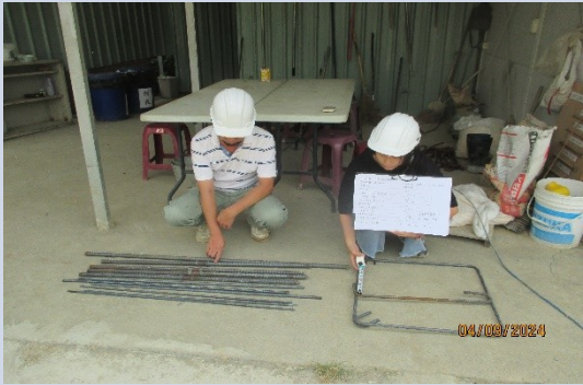
鋼筋尺寸確認、材料取樣
