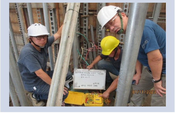
機電技師現場督導
