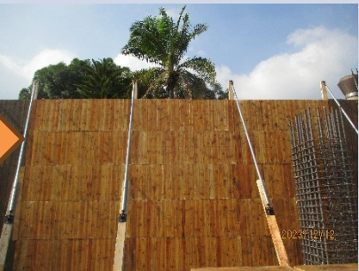
7. 施工模板表面表面上油、垂直度確認
