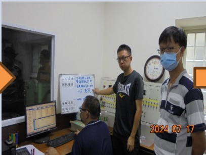
2. 發電機負載測試
