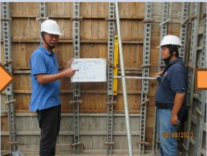
4. 施工：垂直度、緊接器、保護層
