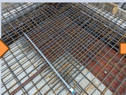
6. 角隅補強確認
