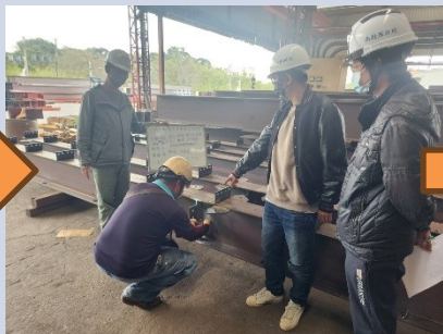
6. 工廠焊道 MT、VT 檢測
