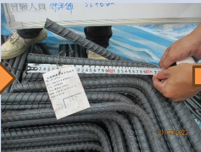
3. 彎鉤長度確認 (≥ 12db、6db)
