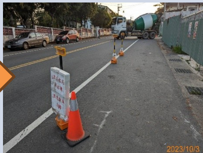
8. 控管澆置時間（道安交管設置）
