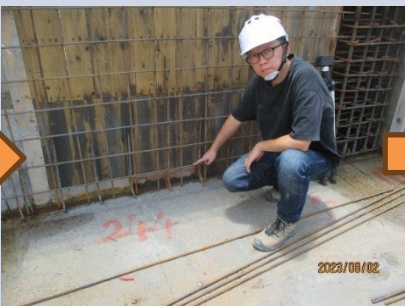
3. 上油，封板前底部清潔確認
