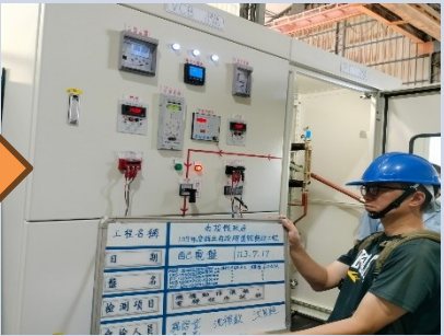
4. 機構動作儀表程序測試
