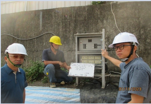
臨時用電安裝漏電斷路器
