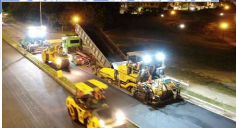
架設9米平衡梁鋪築-不只刨平、更要鋪平
