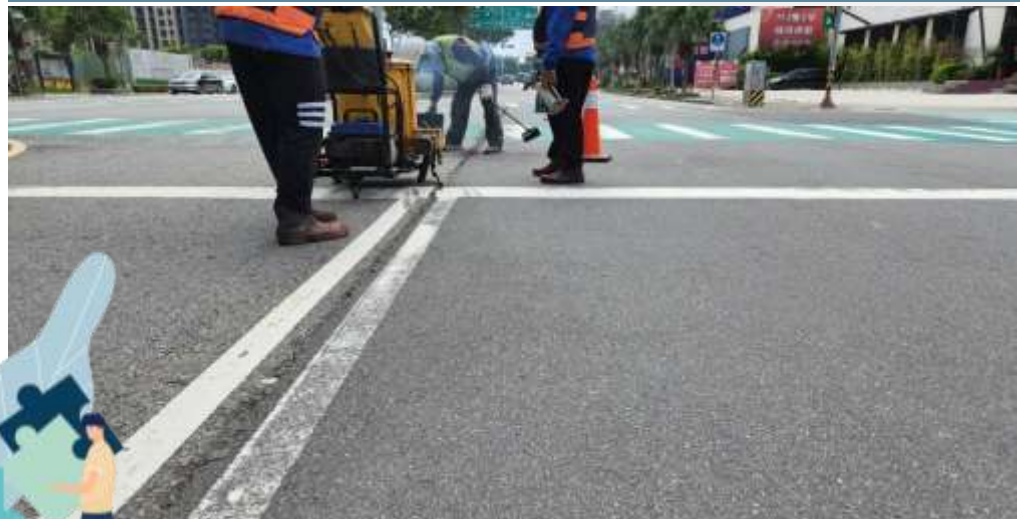
裂縫修補新材料
