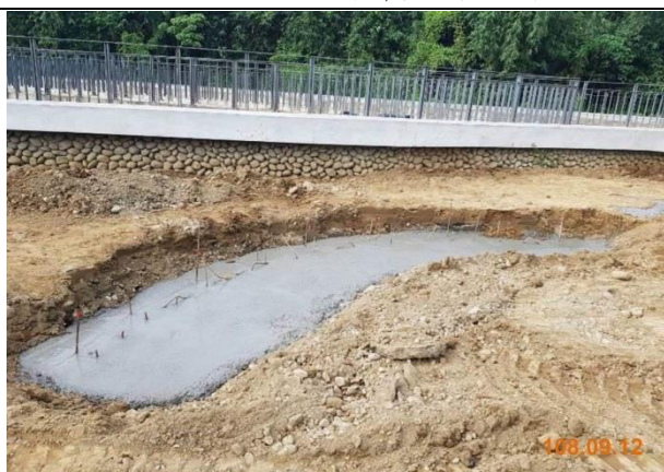
108/9/12 施工中弧形座椅照片
