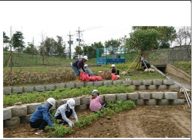
108/3/30 施工中灌木種植照片
