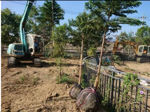
107/11/15 施工中移植喬木種植照片
