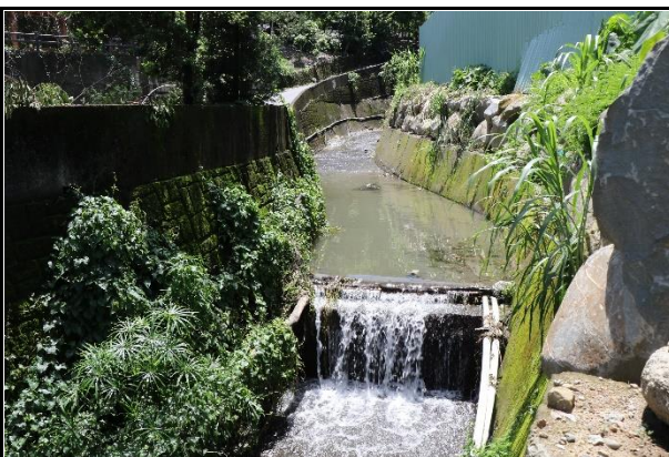
盡量改善既有落差較大之固床工
