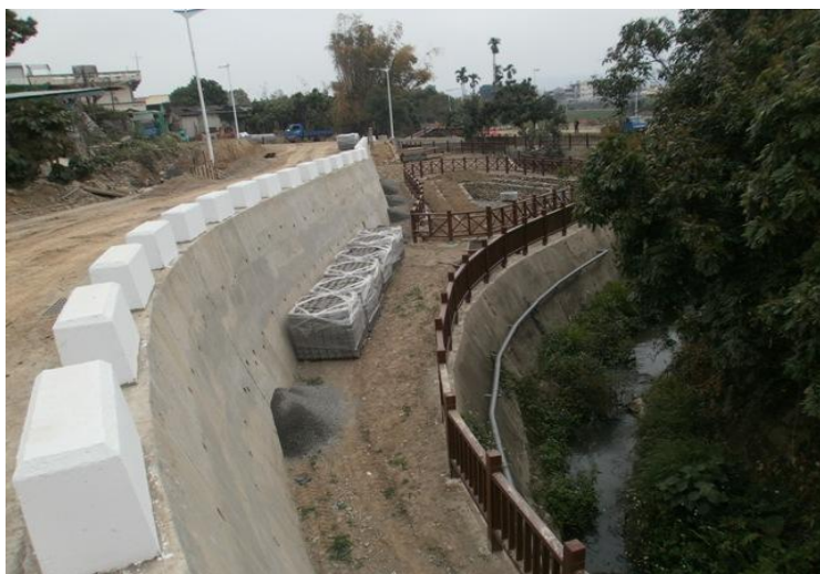
污水自然淨化設施-施工中照片
