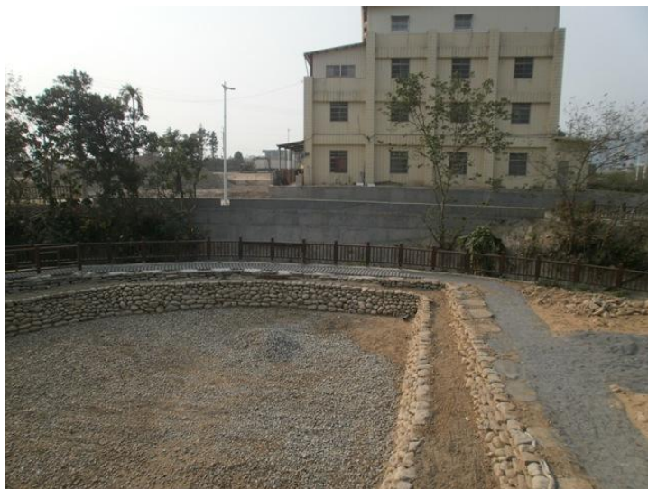
滯洪池設施-施工中照片
