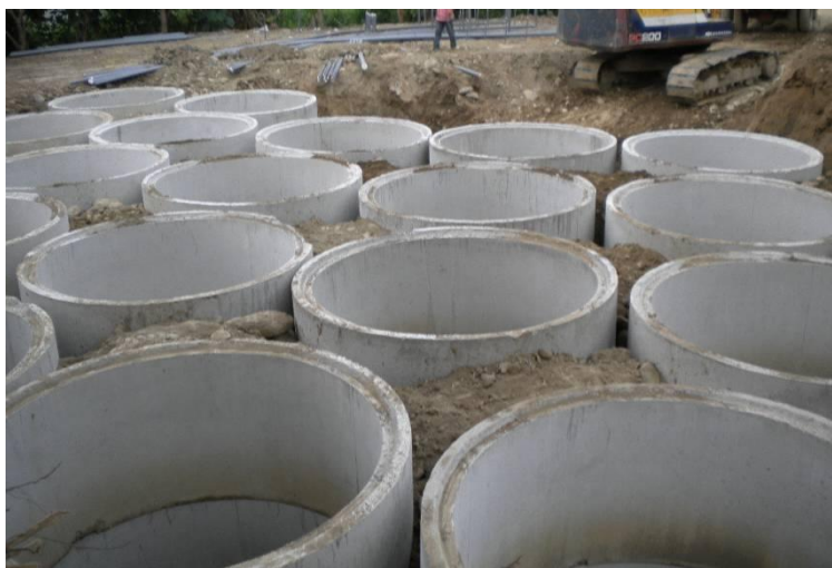
污水處理設施-施工中照片
