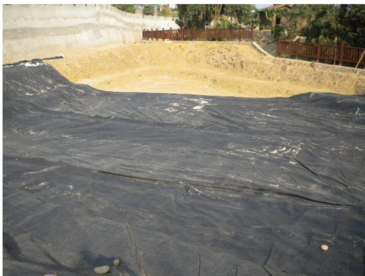
滯洪池設施-施工中照片
