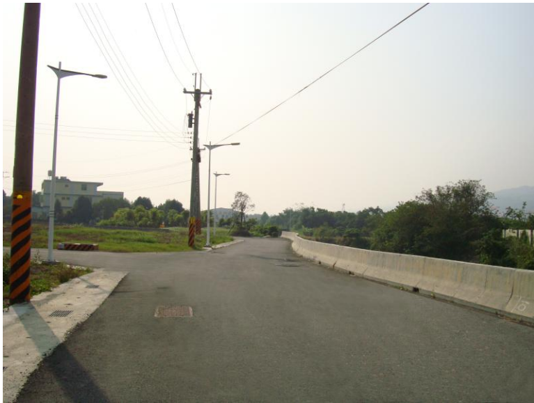
污水處理設施-施工前照片
