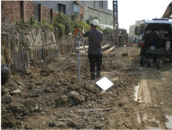
B 段擋土牆-施工中照片
