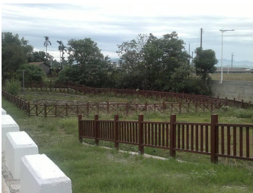
滯洪池設施-施工後照片
