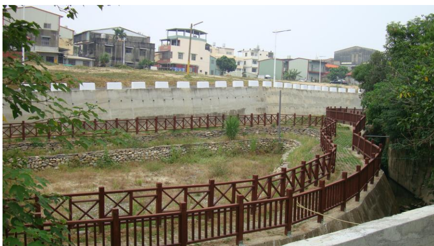
滯洪池設施-施工中照片
