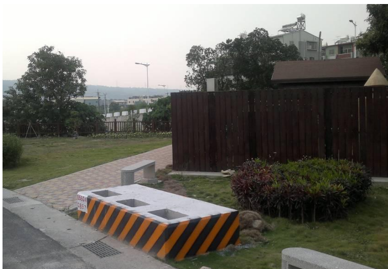
污水自然淨化設施-施工前照片
