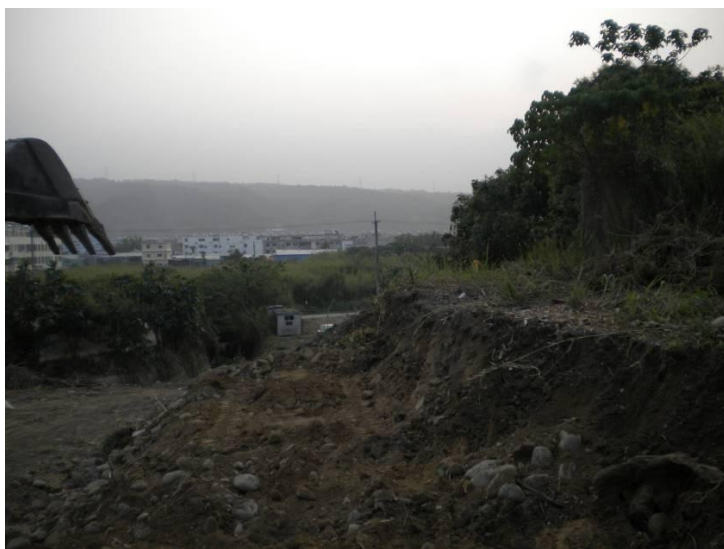
滯洪池設施-施工中照片
