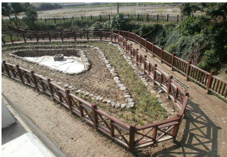
污水自然淨化設施-施工中照片
