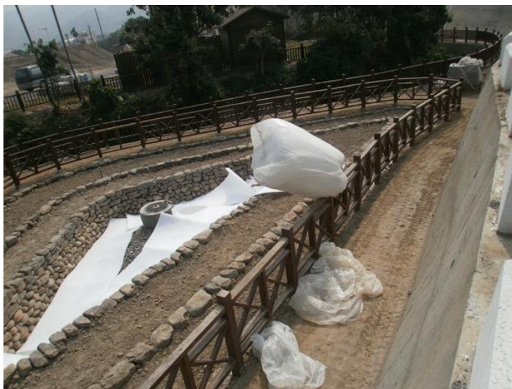
污水自然淨化設施-施工中照片
