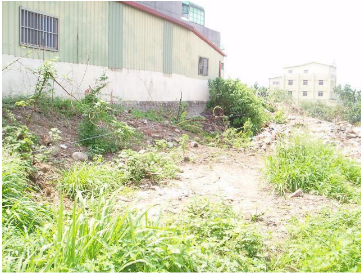
B 段擋土牆-施工中照片
