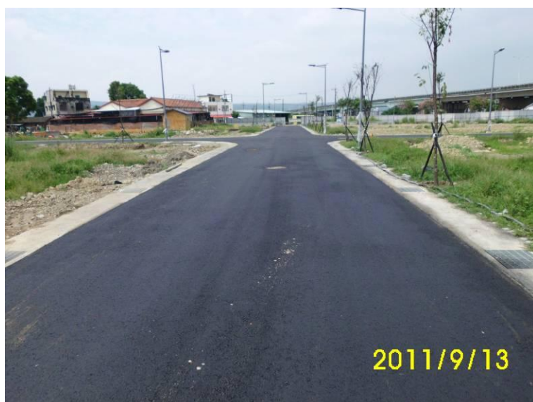
8M-1 道路 - 施工後
