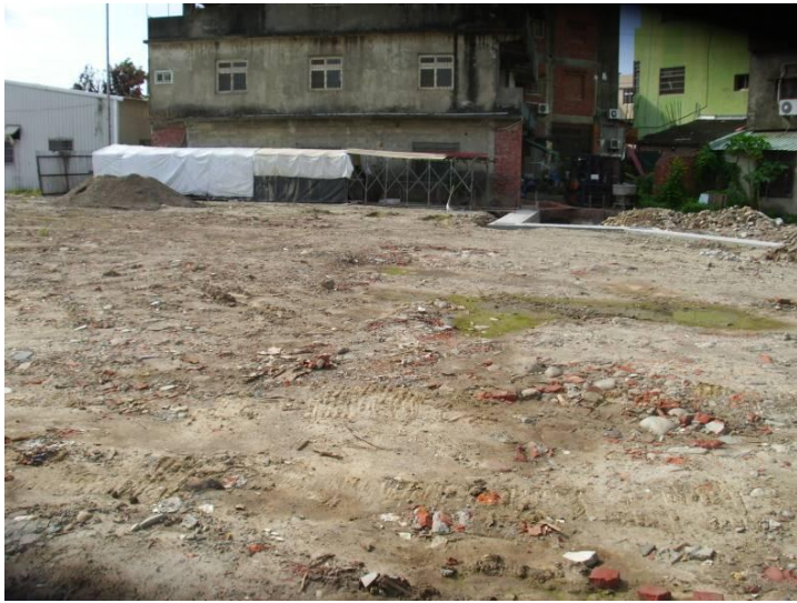
透水廣場-施工中
