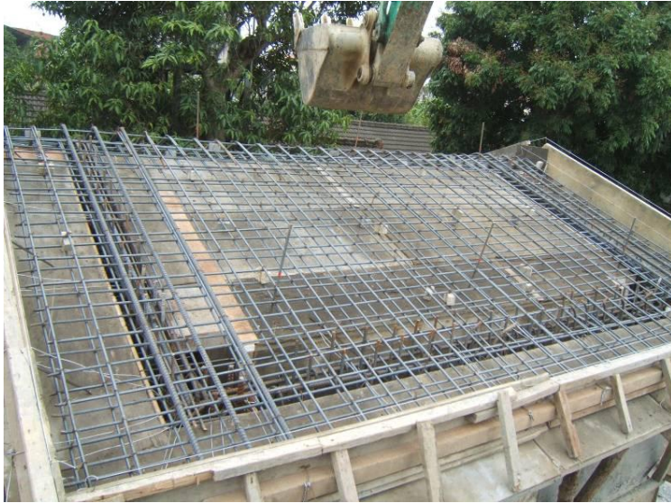
污水處理設施-施工中
