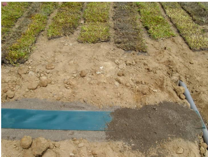
滯洪池-施工後
