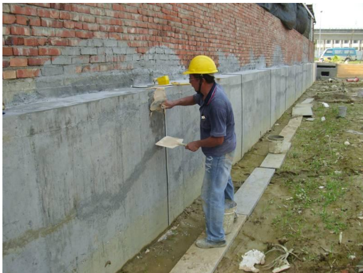
滯洪池-施工中
