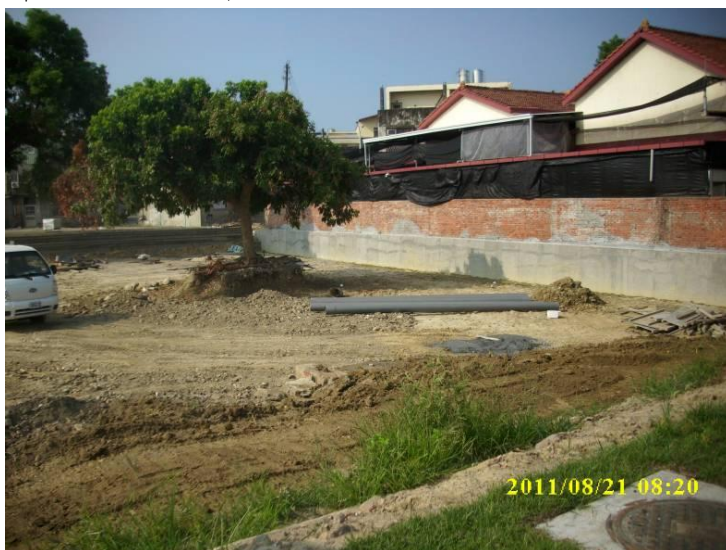
滯洪池-施工中
