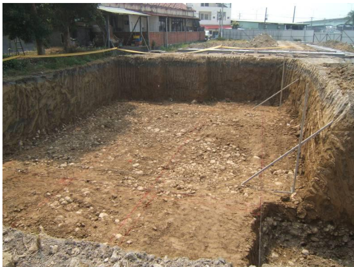
污水處理設施-施工中
