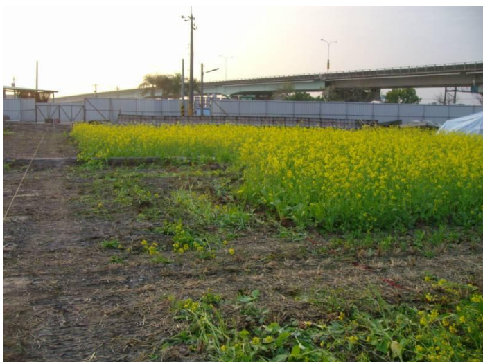
8M-1 道路 - 施工中
