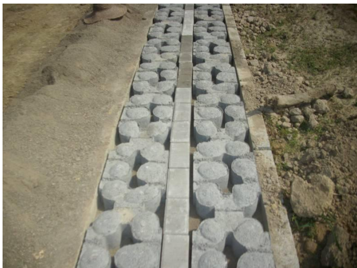
污水處理設施-施工前
