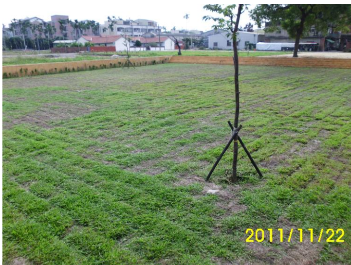
滯洪池-施工後
