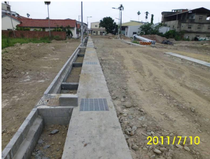
8M-2 道路- 施工後
