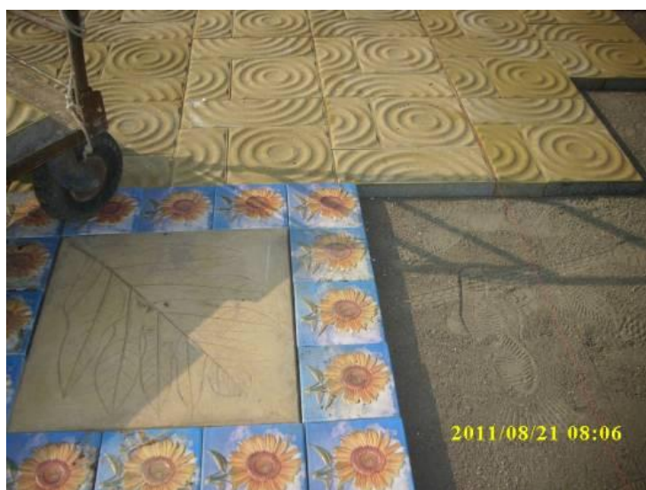
透水廣場-施工中
