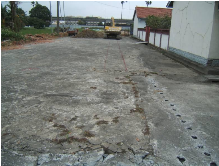
8M-2 道路- 施工中
