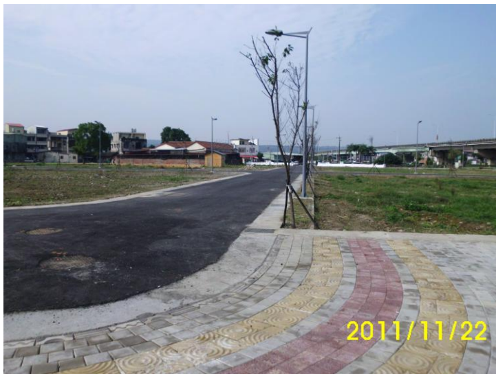
8M-1 道路 - 施工後
