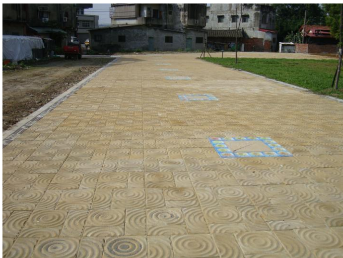
透水廣場-施工後
