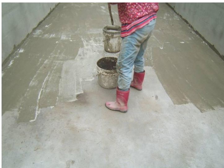
污水處理設施-施工中
